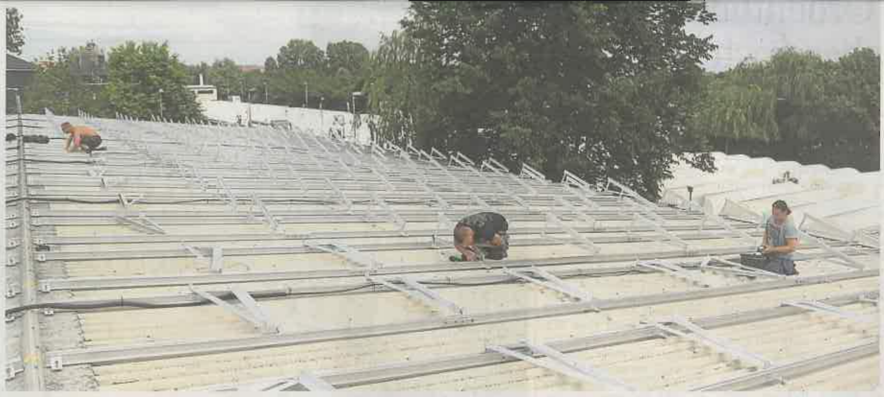
Am Dienstag sind die Handwerker noch dabei, Gestelle auf das Dach des Vorklärbeckens zu schrauben. Die eigentlichen Solarpanels zu installieren, sei kein großer zeitlicher Aufwand, so die Betreiber. Auch die Verkabelung sei schon fertig, sodass man voll im Zeitplan liege. Foto: Vollformat/Volker Dziemballa
